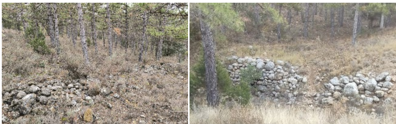
Restos de muros y muros en ruinas
